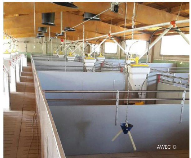
Imagen 04 Nave de engorde.
